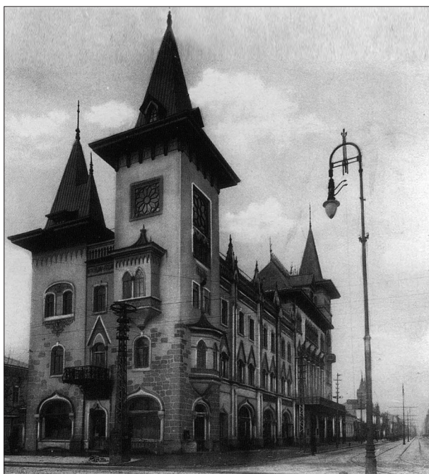
Здание Саратовской консерватории времени её открытия, 1912 г.
